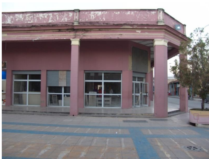
Fig. 1. Tienda Boulevard en reconstrucción general. Edificación sin acceso a la cubierta.
