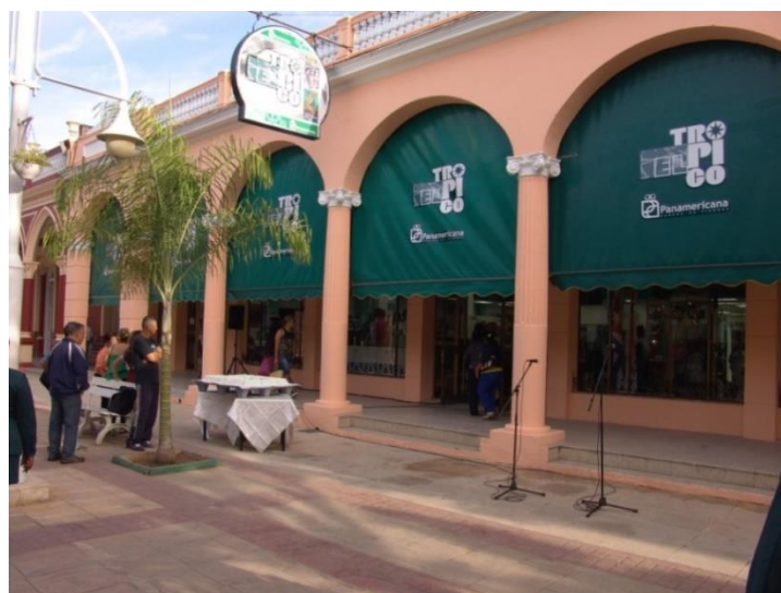
Fig. 2. Tienda El Trópico recién realizado un mantenimiento planificado. Edificación con acceso a la cubierta a través de inmueble aledaño.
